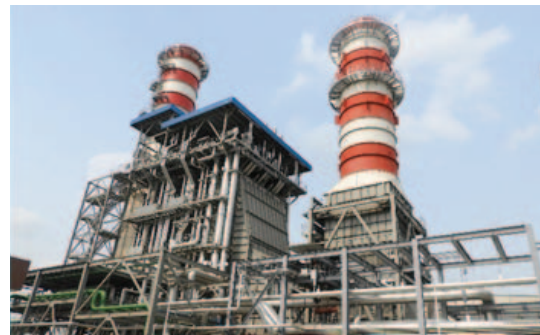
Main Stack, HRSG & Bypass Stack
